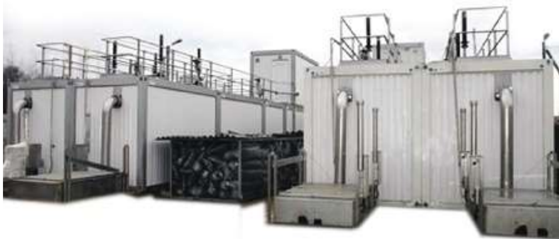
Рисунок 10 – Компактные очистные сооружения глубокой биологической очистки сточных вод блочно-модульного типа «БИОКОМС»
