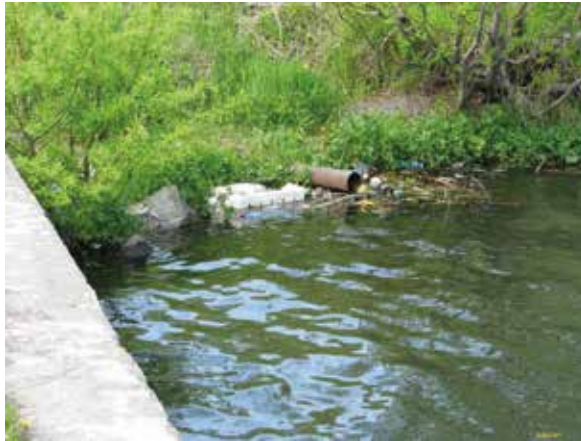
Рис. 7. Юго-западное побережье озера. Выведенная в озеро труба
