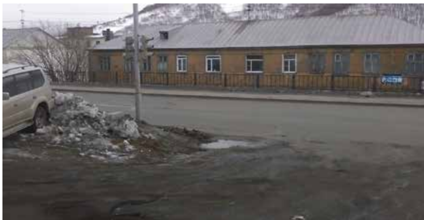
Рис. 1 . Фотография утечки хозяйственно-бытовой канализации по ул. Ключевская, 35, поступающей в дождевую канализацию, имеющей выпуск в озеро Култучное, 15.02.2017 года (фото авторов).
