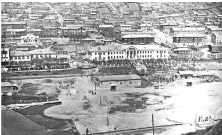
Рис. 28. Строительство стадиона «Спартак», 1956 г. (из фондов ККОМ)
