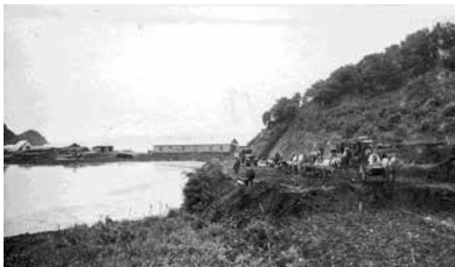
Рис. 16. Прокладка дороги по будущей улице Микояновской (ныне Ленинградская)
