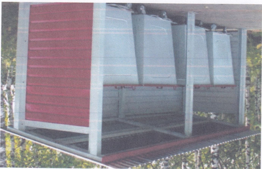
Контейнерная площадка для сбора и хранения ТКО
