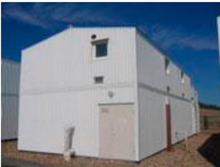
Рис. 14 Внешний вид очистных сооружений «Биоресурс»
